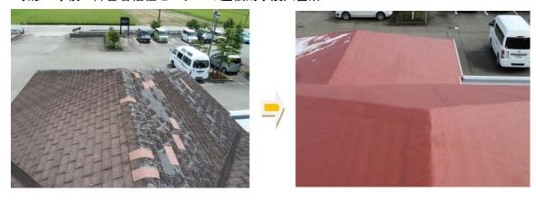
改修工事前 渡り廊下の雨水侵入箇所
